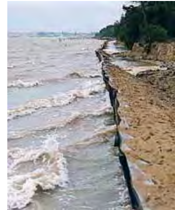
Defensas contra la erosión del río.
